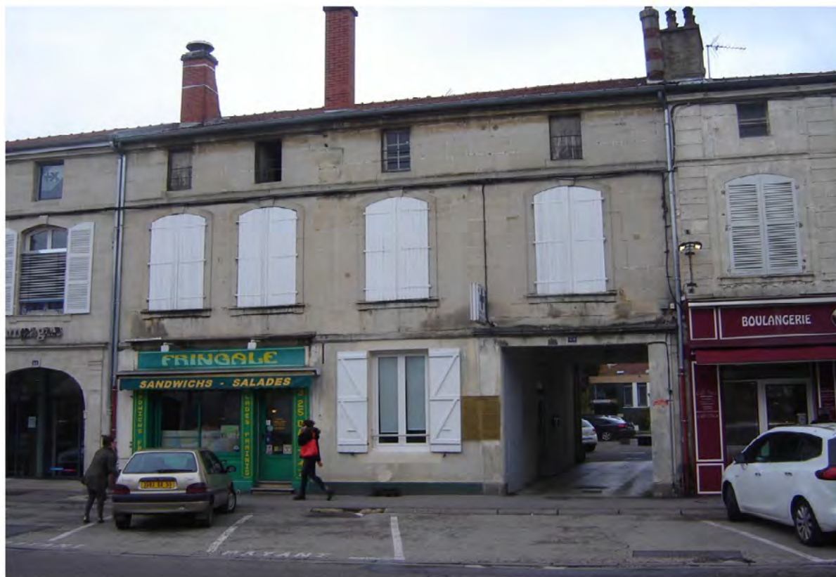
n° 60 : relai de poste au 18 e siècle
