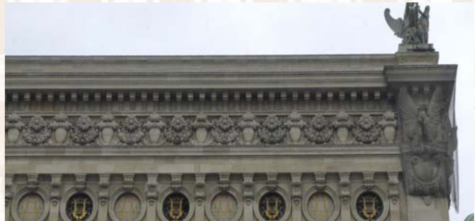
Baie du 1er étage, masques de la façade principale, lyres de oeils-de-boeuf - Photos personnelles du 2/5/2013 et 1/2/2013
