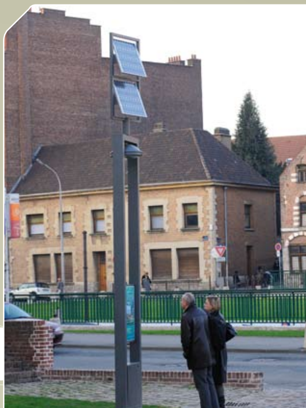
Installation d'un ensemble d'éclairage autonome
