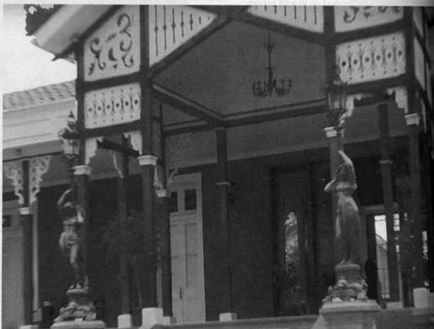
Fig.6 Torchères en zinc signées A. Carrier - Casa de la Cultura San Bernardo- Santiago du Chili. Ce modèle est édité en zinc par l'entreprise Boy en 1867- Paris) qui a beaucoup exporté. (Photo DP RIFA 2014) Ce modèle, édité en zinc, était aussi édité en bronze par Durenne.
